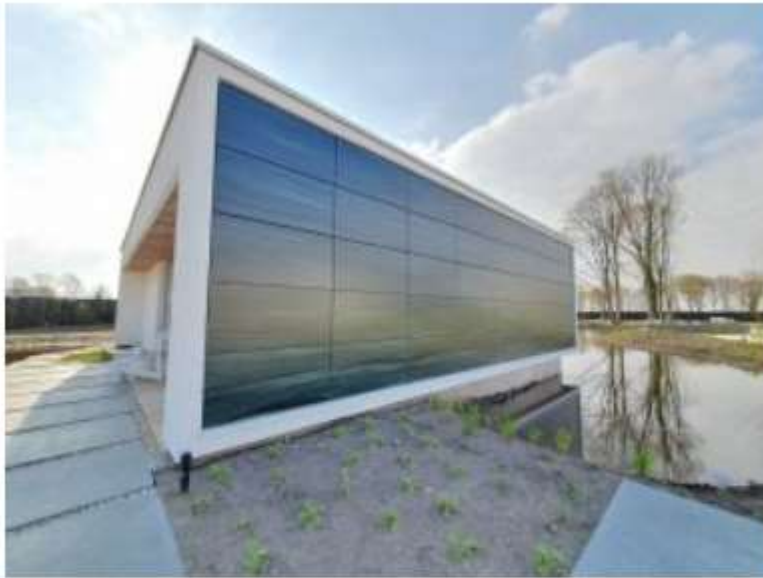
Zonnepanelen op de gevel: een interessant alternatief. Bron: Ecopuur
