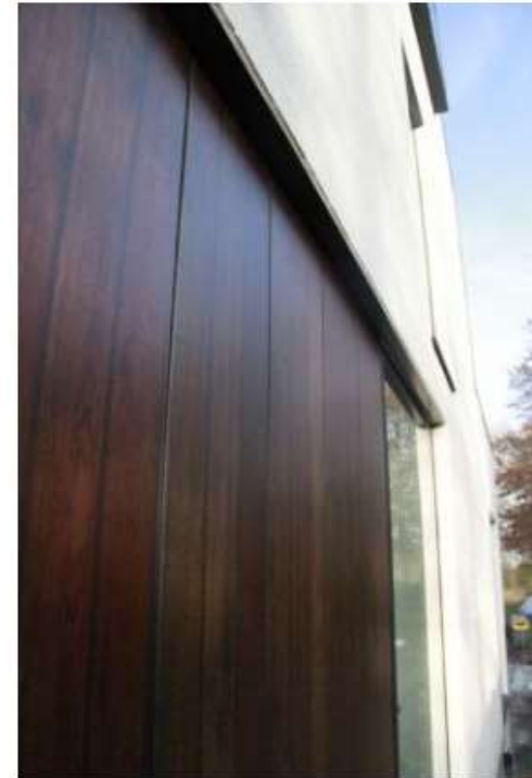
Een houten gevel en zonnecellen zijn niet meer te onderscheiden. Bron: Ecopuur
